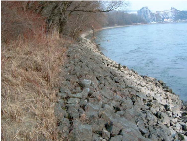
Abb. 60: Linkes Donauufer bei Strom- km 1880,8; Blick talwärts (gegen Osten); Aufnahme ca. Jänner 2005; Bildnachweis: DonauConsult
