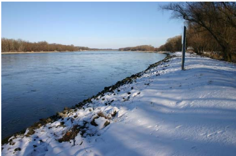
Abb. 57: Rechtes Donauufer bei Strom-km 1904,2; Blick talwärts (gegen Osten); Aufnahme ca. Jänner 2005, daher tw. Schneebedeckung; Bildnachweis: DonauConsult
