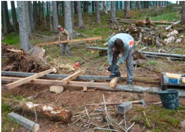
Reparatur des Themenwegs „Wollgras, Alm und Wasserschwinde“.
