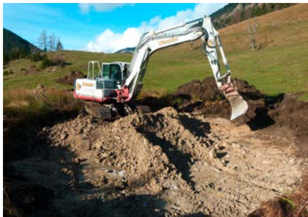
Grabungsarbeiten für das neue Biotop auf der Puglalm.
