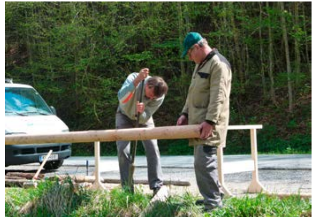
Errichtung der neuen Parkplatz-Beplankung
