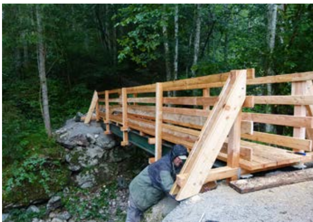
Errichtung der neuen Holzbrücke über den Salzabach.
