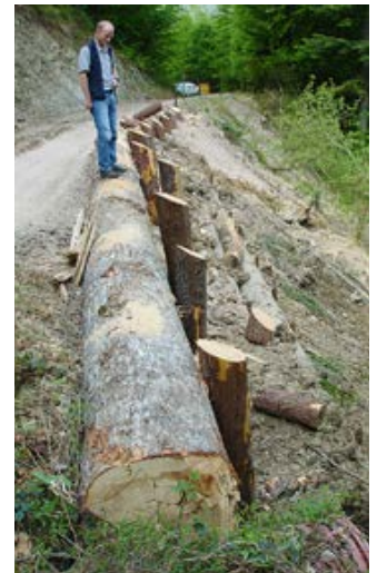
Sanierung der Rutschung auf der Schaumbergalmstraße.
