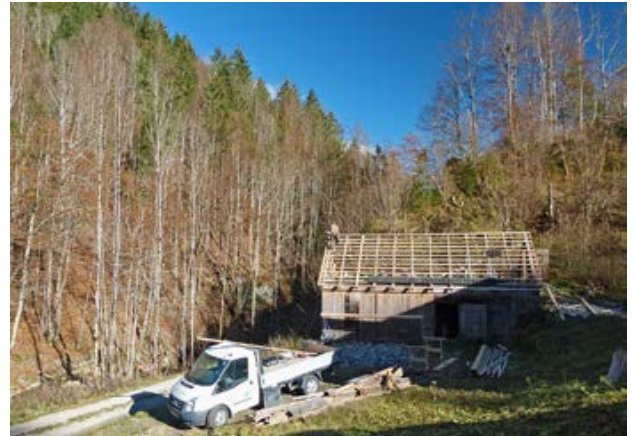
Neueindeckung des Stadel im Vorderholzgraben.
