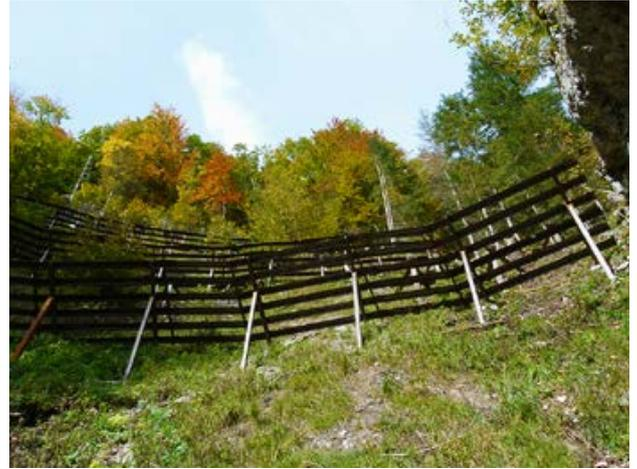
*Stahlschneebrücken verhindern das Abreißen von Lawinen.*
