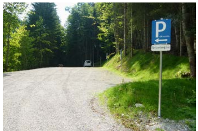
Neu errichtete Parkfläche am Hengstpaß mit 30 Stellplätzen.
