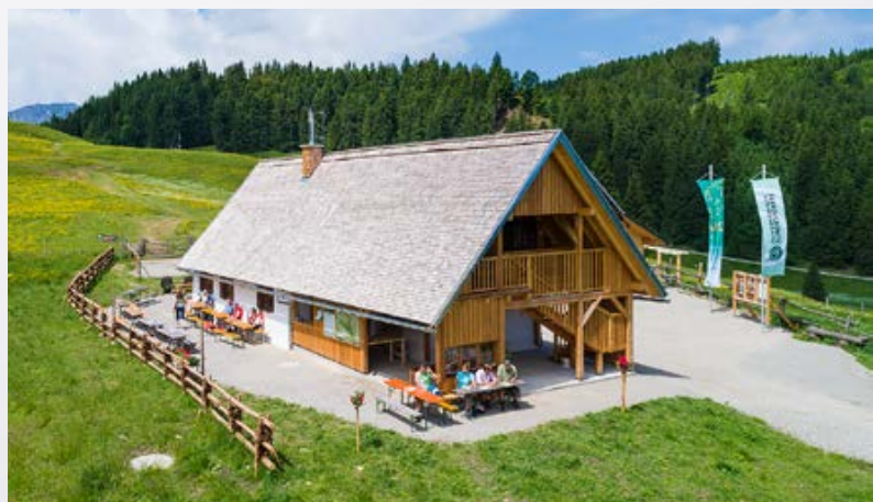
Die renovierte Ebenforstalm hält im Zubau Informationen zum Nationalpark Kalkalpen bereit. | Foto: G. Egelseer
