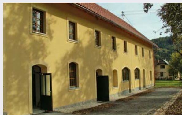
Das im Februar 2006 durch Schneedruck zerstörte Wirtschaftsgebäude erstrahlt seit Sommer 2007 wieder in neuem Glanz.
