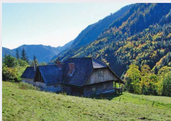
Das ehemalige Jagdhaus Hinterholzgraben wurde 2007/08 zum WildnisCamp umgebaut.
