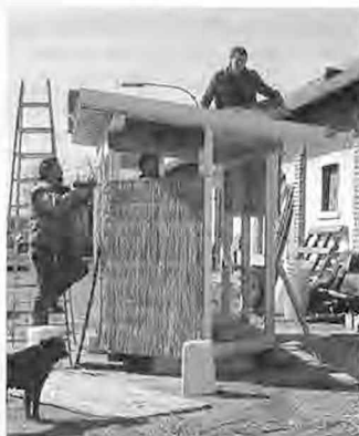
Gerade am Apetloner Hof fertiggestellt: das neue Hide für die Hölle
