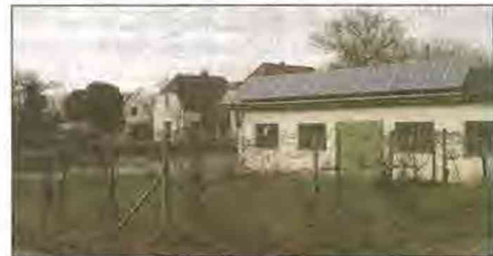
Auf dem Arbeitsschuppen: die neue Photovoltaikanlage.
