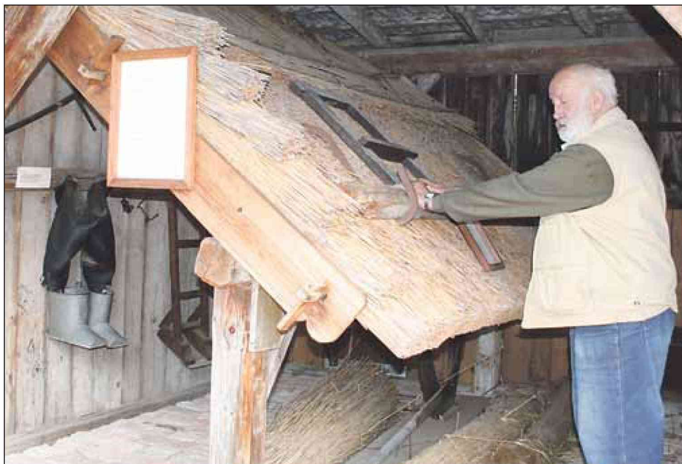
Schilfdächer sind heute so selten wie Schilfdachdecker. Von der winterlichen Ernte bis zur Herstellung einer langlebigen Dachdeckung wird hier alles präsentiert.
