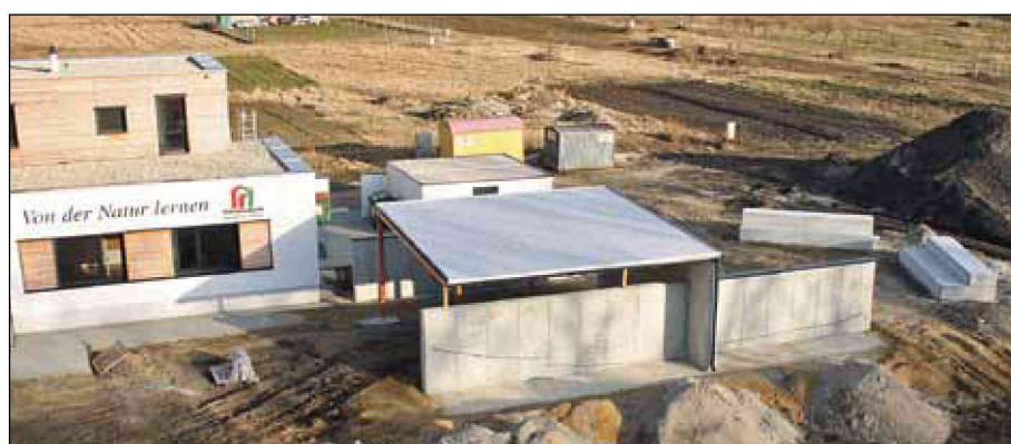
Stützwände und Dach des „Freiluftklassenzimmers“ konnten noch vor dem Winter fertig gestellt werden, bis Ostern folgt die Gestaltung des Grünbereichs.
