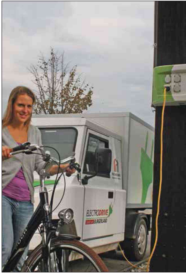
Bis zu vier Elektrofahrzeuge können gleichzeitig ab sofort beim Nationalpark-Infozentrum betankt werden.
