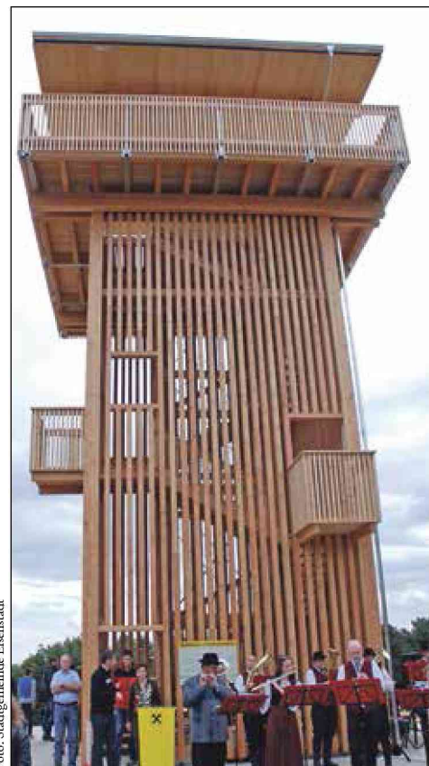
Die Jubiläumswarte auf der so genannten Parapluie-Höhe oberhalb von Eisenstadt wurde am 15. September eröffnet.
