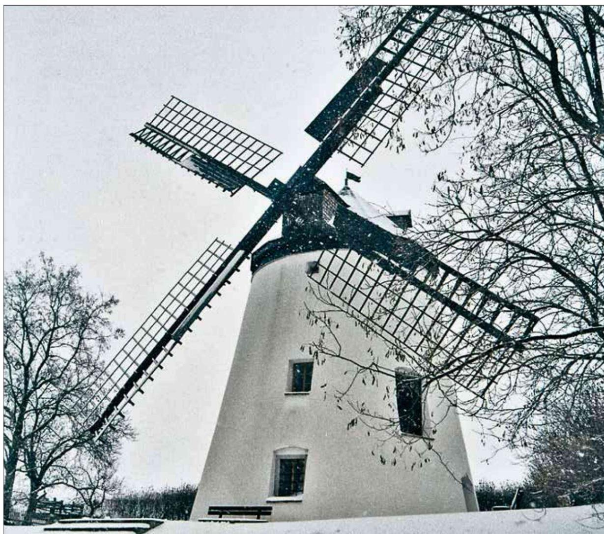
Auf den ersten Blick sieht die letzte burgenländische Windmühle gut erhalten aus, die Probleme stecken aber im Detail: Von der Mauertrockenlegung über die Lagerung des Rollenkranzes bis zum Tausch von Holzteilen gibt es viel zu tun.
