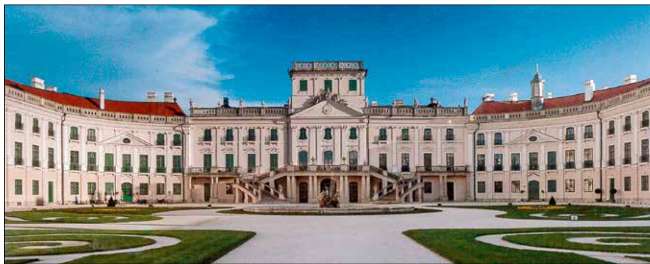
Deutlich erkennbar waren meist nur die Renovierungsarbeiten am Hauptgebäude. In neuem Glanz zeigen sich jetzt aber auch Puppentheater, Orangerie und Verwaltungsgebäude, wiederhergestellt wurde zudem der Rosengarten.
