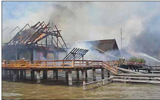
Letztendlich sind 10 Seehütten durch den Brand völlig zerstört worden, fast ebenso viele konnten vor den Flammen gerettet werden.
