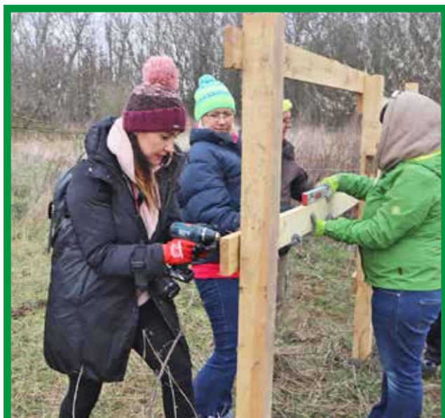
Vom Schreibtisch an den Koppelzaun An einem eher feuchtkalten Dezembertag machten sich fünf Damen und ein Herr von Canon Central and Eastern Europe von Wien aus auf den Weg in den Seewinkel, um im Nationalpark an der Errichtung eines Koppelzauns im Seevorgelände Hand anzulegen. Mit Unterstützung durch Nationalparkmitarbeiter (und schwerem Gerät) war bis am Spätnachmittag ein respektabel langer Zaunabschnitt fertig gestellt. Das Canon CEE Team hat dabei nicht nur wertvolle Naturschutzarbeit geleistet, sondern auch viel über die Aufgaben eines Nationalparks – vor allem im Naturraummanagement – gelernt.
