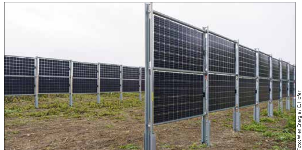
Die Ost-West-Ausrichtung der Module sorgt für einen besonders hohen Strom-Ertrag.
