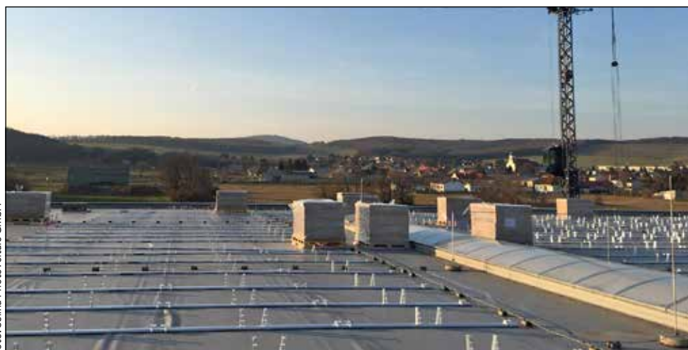
Selina hat die PV-Anlage in Edelstal als Contracting-Modell realisiert: Die 15 Volleinspeiser-Anlagen werden von Selina betrieben, an Coca Cola wird eine Dachmiete bezahlt.
