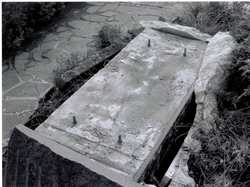
Abb. 2: Abdeckung durch Marmorplatten.
