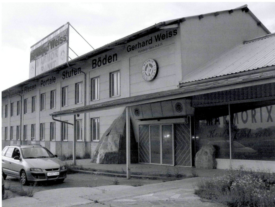
Abb.1: Firmengebäude in Gerasdorf bei Wien, NÖ.
