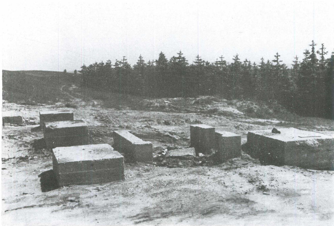
Abb. 9: Nordöstlicher Schonungsrand, im Vordergrund Reste der Bohranlage (1961).
