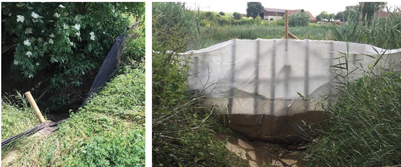
**Abb. 10:** Sedimentauffangzaun (links) und Filterdamm (rechts) nach dem Starkregenereignis am 01.06.2018 (Hinweis: Filterdamm an der Basis gerissen); Fotos: Gregor Lützenburg, 2018.
