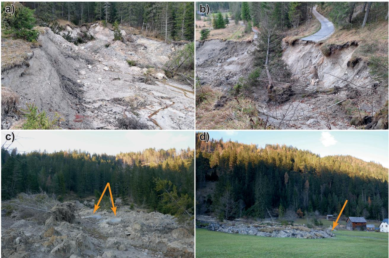
**Abb. 2:** Erdstrom Hinterwildalpen. a) Blick in die Anrisskante; b) Blick von der Anrisskante. Deutlich erkennbar ist die zerstörte Straßenkehre der Asphaltstraße; c) Blick in den Transitbereich des Erdstroms. Die orangen Pfeile markieren Reste der Asphaltstraße; d) Akkumulationsbereich des Erdstroms mit deutlich erkennbarem Stirnwulst. Der orange Pfeil markiert den Austritt des Gerinnes aus der Massenbewegung, das nun über die Wiese abfließt (Fotos: Autoren).
