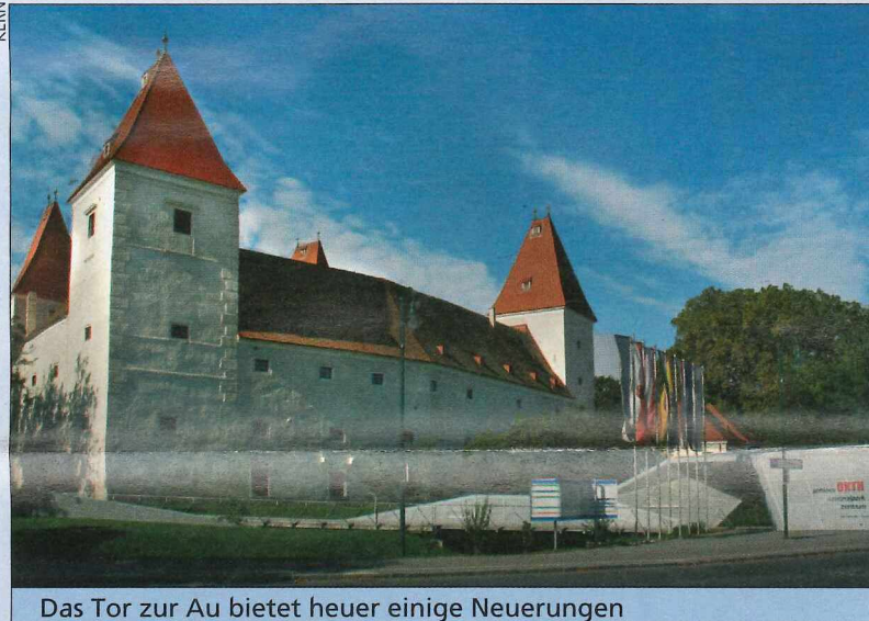
Das Tor zur Au bietet heuer einige Neuerungen
