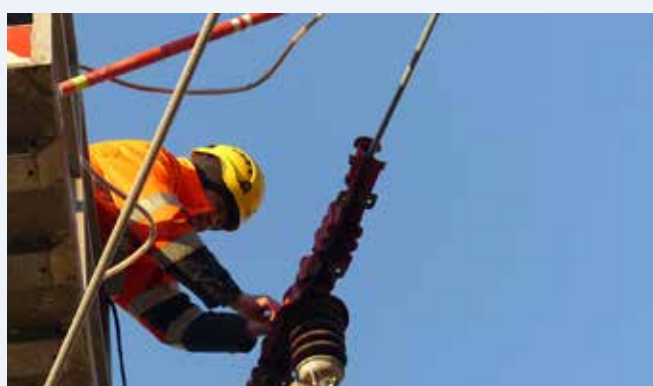
Stromleitungen werden vogelsicher – ein Erfolg der Bemühungen von DANUBEPARKS.
