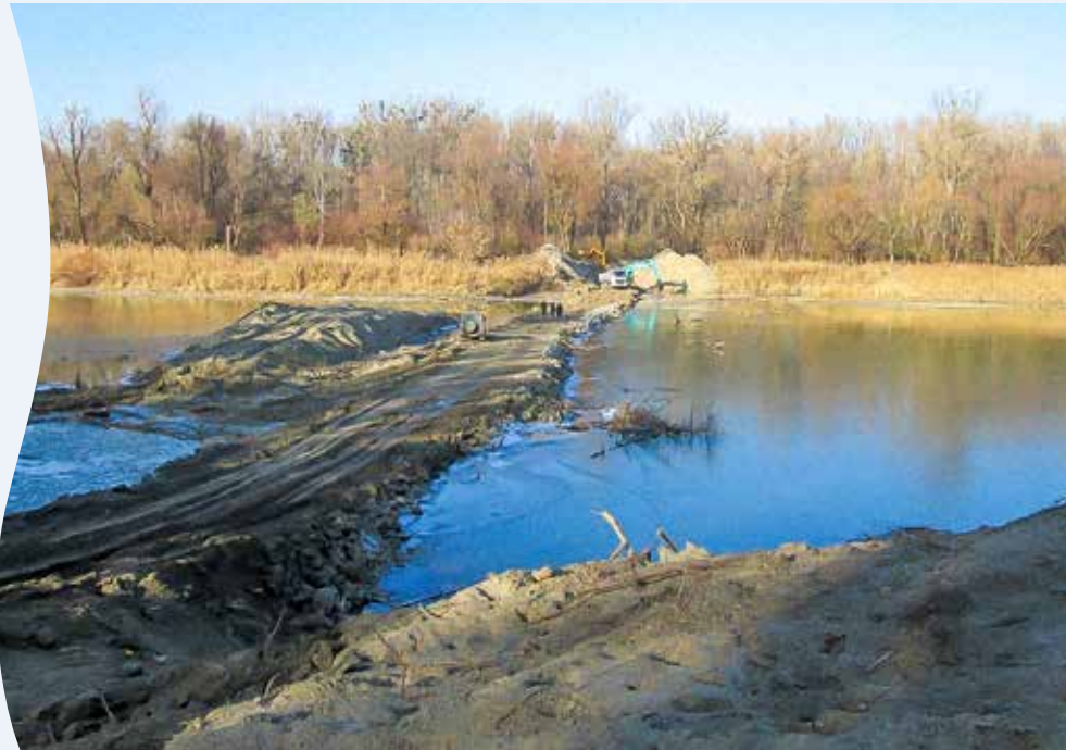
Am Spittelauger Arm wurden unter anderem Traversen als Barrieren entfernt. Nun wird der Gewässerzug wieder intensiv durchströmt.
