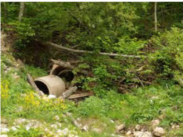
Abb.42 Eine alte Verrohrung verhindert das natürliche Einmünden des Seitengewässers. (Foto A. Eckelt)
