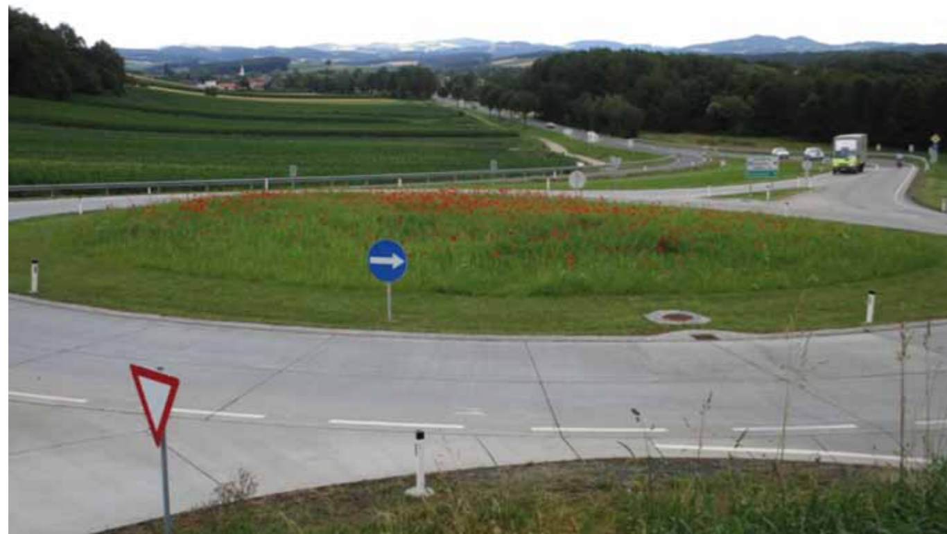
■ Durch das BBS bepflanzte Kreisverkehrsgrünfläche im Raum Oberwart
