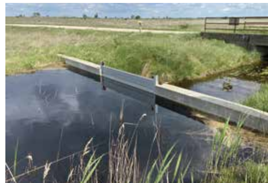
■ Rückstauanlagen an Entwässerungsgräben als Maßnahme zur Klimawandel-Anpassung Foto: NP
