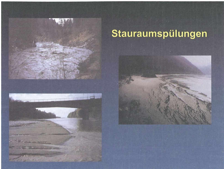
Abb. 9: Bolgenach – Stauraumspülung (Bilder links) und abgesenkter Donaustauraum.
