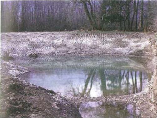
Abb. 26: Totarm - Unterhalb der Doppelbucht befindet sich nun das Bett eines Totarmes, der über eine Flutmulde mit der Bucht in Verbindung steht. Eine Hakenbuhne unterhalb des Totarmes sichert das Hinterland.
