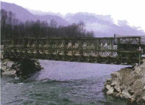
Abb. 9: Behelfsbrücke - Die Bauarbeiten für den Bauteil West erfolgten unter großem Zeitdruck, da die für die Baumaßnahmen notwendige Behelfsbrücke nur bis Ende April standsicher war.
