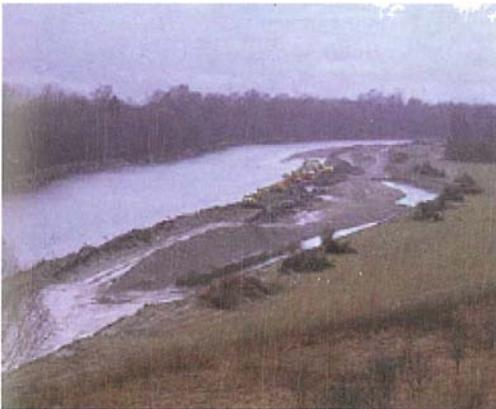
Abb. 7: Während der Bauarbeiten - Die alten Ufersicherungen werden zurückversetzt, die Uferböschungen abgeflacht. Das Aushubmaterial wird teilweise als Geschiebeinsel im Fluss belassen. Damit werden dynamische Umlagerungsprozesse initiiert.
