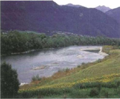
Abb. 8: Nachher - Eine Flussaufweitung mit abwechslungsreicher Uferlinie entstand. Die Geschiebeinsel wurde durch ein Hochwasser bereits großteils abtransportiert.
