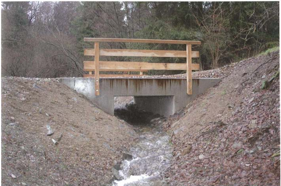
Abb. 5 Haubenprofil mit Niedrigwasserprofil im Bauwerk kurz nach der Fertigstellung
