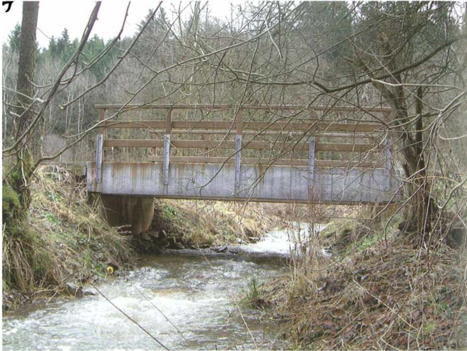
Abb. 6 Stahlbetonbrücke aus dem Ziel2-Projekt "Hellenthaler Ländchen"
