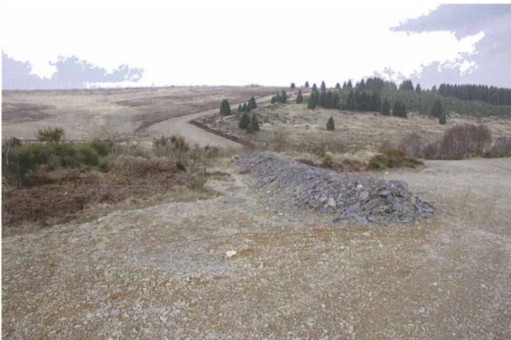
Abb. 8 Sedimentsperre auf dem Truppenübungsplatz Elsenborn (Belgien). Bevor der mit Feinsediment belastete Oberflächenabfluss in ein Fließgewässer gelangt, wird er seitlich umgelenkt. Die Feinsedimente setzen sich ab. Das Wasser versickert.
