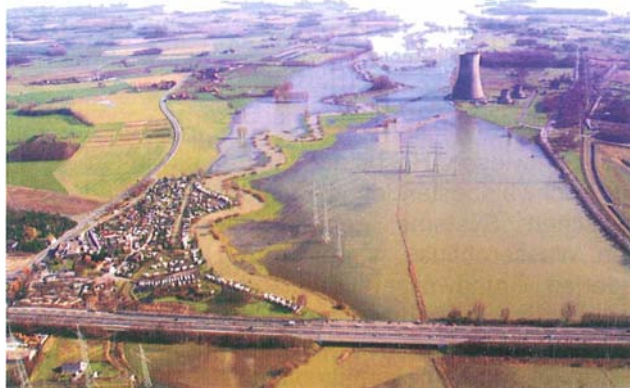
Abb. 3: östliches Projektgebiet. Die bestehende Verwallung am Flussufer ist deutlich erkennbar (hochwasserfrei)
