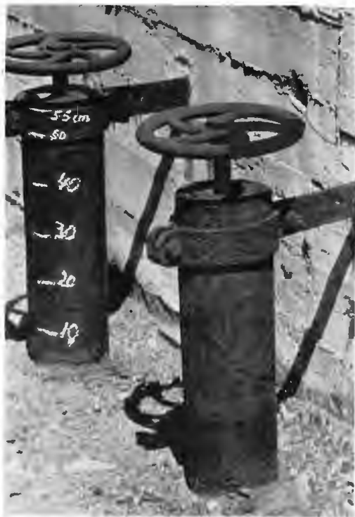
Abb. 3. Nistplatz einer Kohlmeise im Ablaufhahn eines Wasserkühlturmes.
