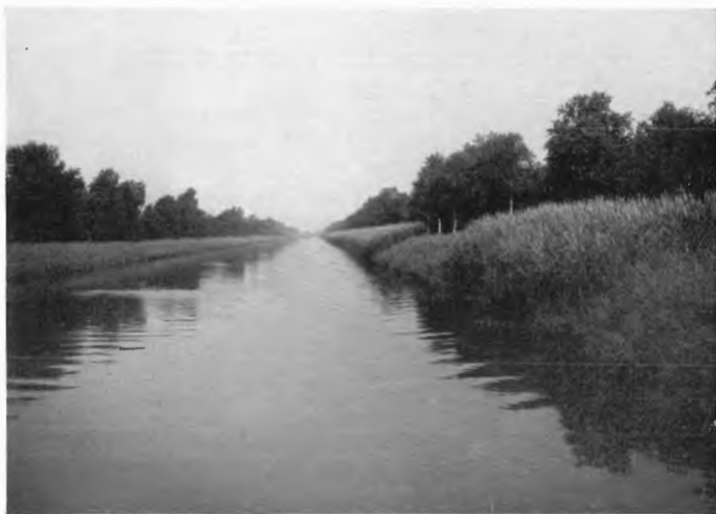
Abb. 1. Kanalstrecke mit beiderseitigem dichtem Schilfrohrgürtel.
