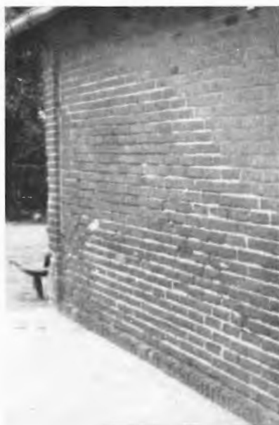
Abb. 1. Mauer eines Schuppens mit leergepickten Mörtelfugen.
