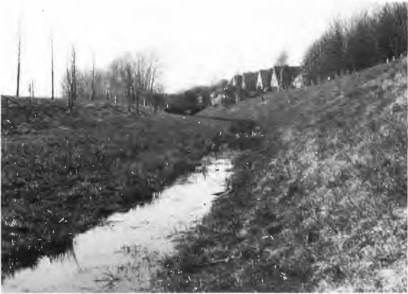
Abb. 1: Regenrückhaltebecken „Rumelner Bach“ (Duisburg) im Februar 1979.
