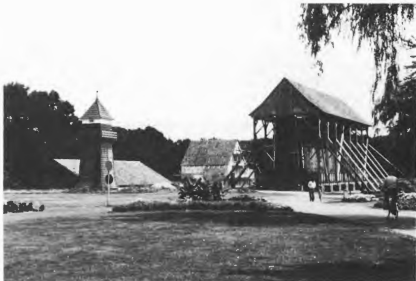
Halophytenstandort zwischen östlichem Gradierwerk (rechts), Turbinenhaus (Mitte), Bohrturm und Solevorratsbehälter (links).
