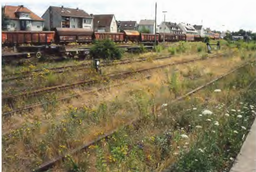
Foto 6: Dicht bewachsene Gleise am Bhf. PB-Nord.
