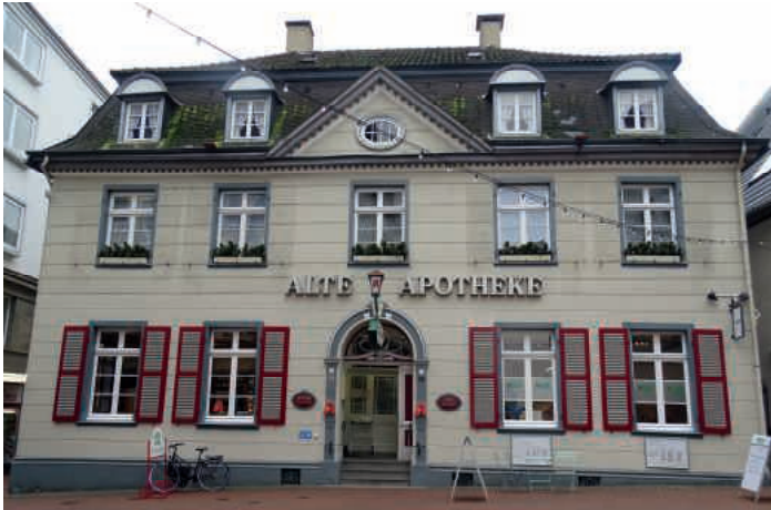
Foto 1: Alte Apotheke in der Breiten Straße in Recklinghausen (Foto: Tenbergen, 2020)
