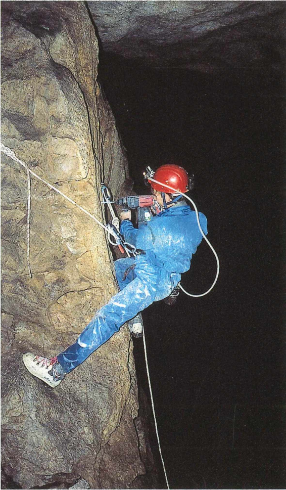
Abb. 6: Schaffung von Befestigungspunkten für eine Abseilstrecke mit der Akkubohrmaschine.
