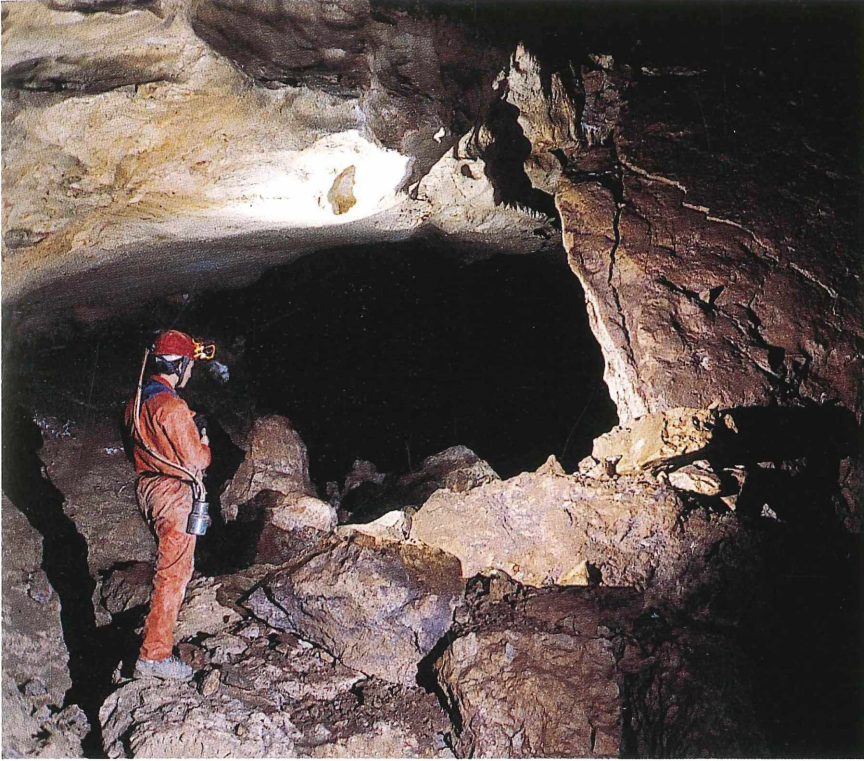
Abb. 9: Decken- verbruch im Hauptgang.
