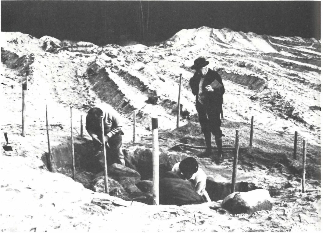
Notbergung in der Sandgrube bei Behringersdorf – ausgraben im Wettlauf mit den Bulldozern
