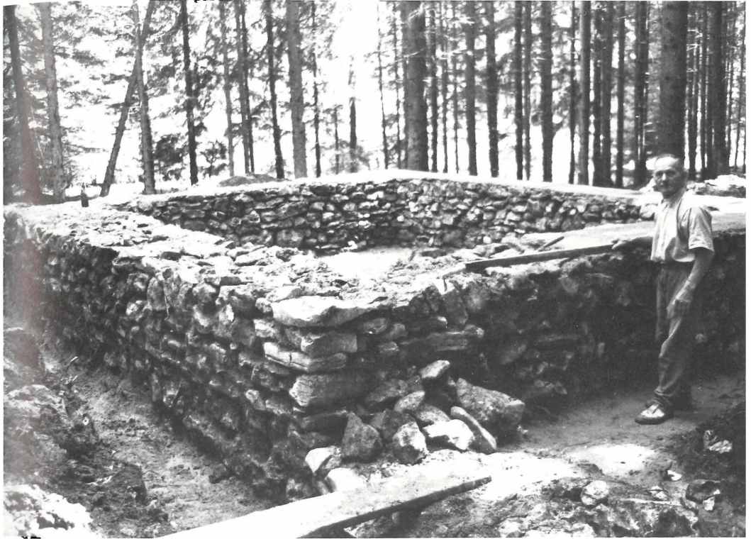
Der Limesturm bei Erkertshofen
