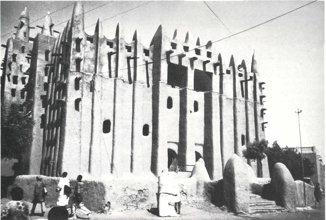
Die Moschee in Mopti „Das Venedig Afrikas“ wurde auf künstlich erhöhten Schwemmseln erbaut. Das „Paket“ in Bildmitte schützt einen frischgepflanzten Baum vor freilaufenden Haustieren. Die Freileitungen erfüllen, wenn auch nicht VDE-mäßig, ihren Zweck.
