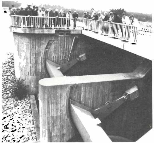
Auf dem Damm der Brombach-Vorsperre Die mächtigen Schilde werden den Wasserstand im Seegebiet links \pm konstant halten. Im Hauptspeicher rechts dagegen wird der meist niedrigere Wasserspiegel jahreszeitlich, bedarfsbedingt \pm stark schwanken. Foto: H. Niebler
