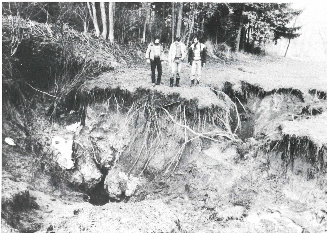
Müllschlucker-Erdfall bei Saaß, Zustand Ostern 1984, Ansicht von O. Rechts in Bildmitte ist der ursprüngliche Einbruch zu erkennen.
