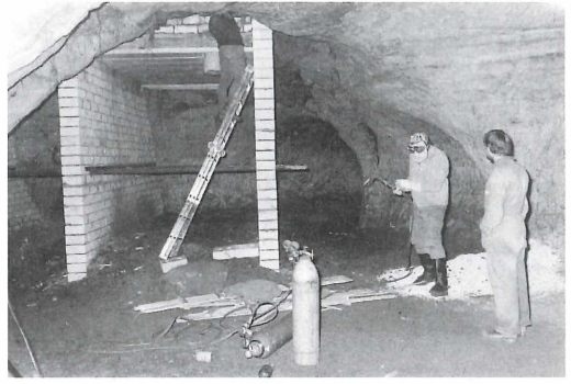
Die fertiggestellte Stützkonstruktion.
