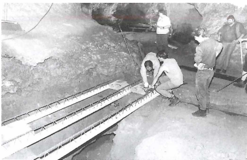
Einbringen der Deckenteile über dem Verbindungsschacht Sophienhöhle – Höschhöhle.
