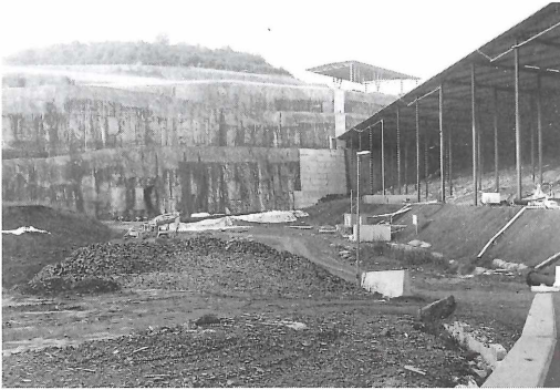
Eingang zur Großen Wirmsthaler Höhle, links in der Steinbruchwand unterhalb der Altlast; rechts die moderne Deponie.
