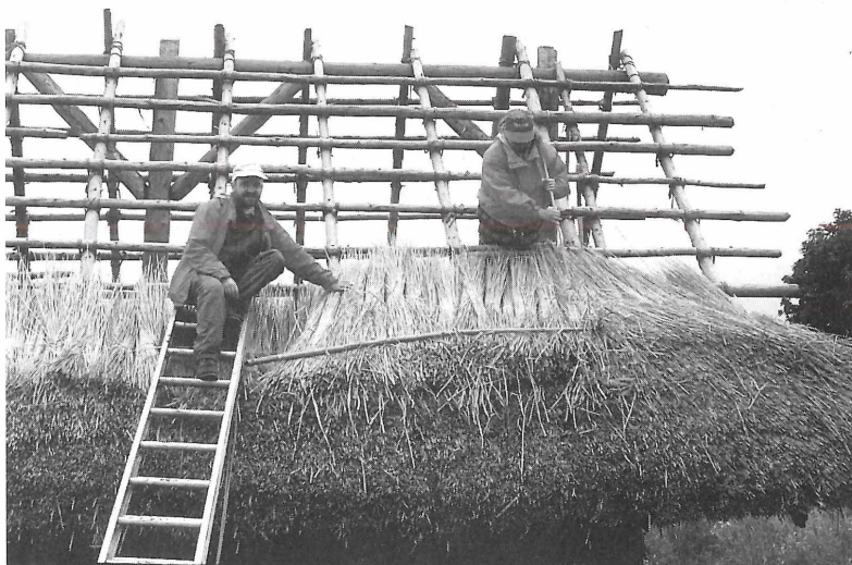
Hausbau in Landersdorf: Das Dach wird mit Stroh gedeckt
