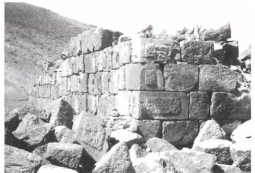
Abb. 9: Detail des Qasr mit geboßen Ecksteinen, die man auch im Versturz erkennen kann.
