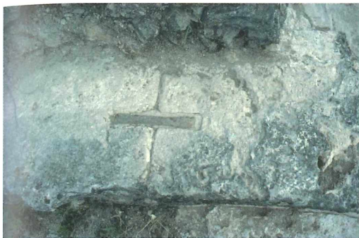
Abb. 22: Eisenklammer im Bleiverguß an der Sockelmauer der Scaenae frons
