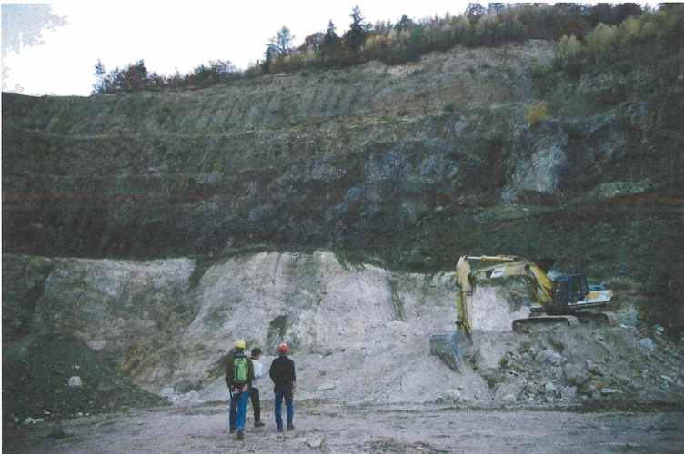
Abb. 2: In Gossendorf wird Traß abgebaut. Der Bagger steht direkt auf diesem Mineralgemenge aus Opal-CT und Alunit. Foto: Calow
