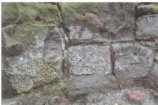
Wandverputz an der Südostmauer des Chores der Kirche in Pillenreuth
